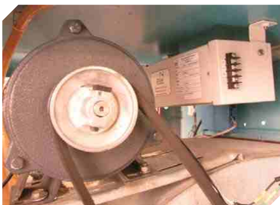
شکل ۱۸: نصب موتور ۵۵۰ وات در داخل کولر آبی
